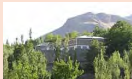
Die neue Schule liegt in der Provinz Badakhshan nahe des Amu-Flusses.
