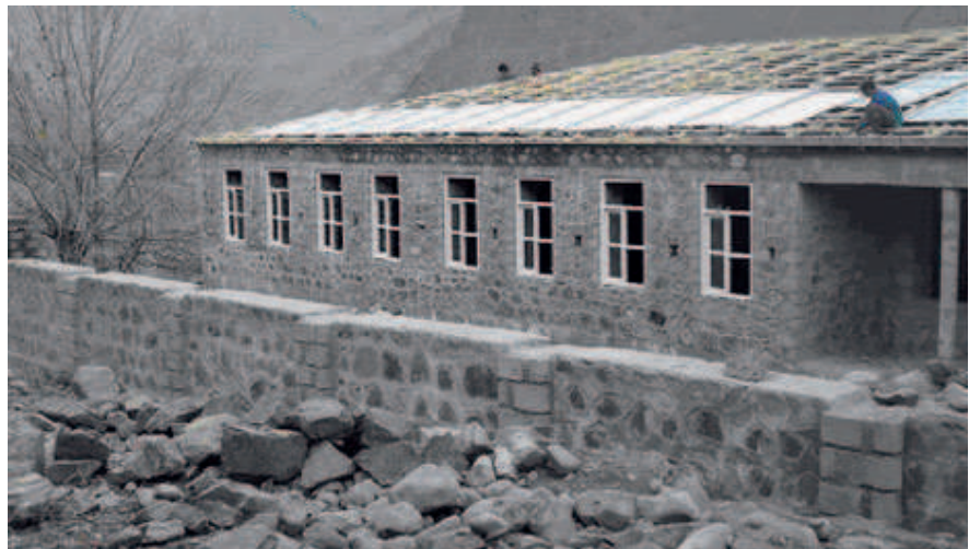
Mario-Keller-Schule – Baufortschritt Frühjahr 2009. Die Mädchenschule entsteht im Norden Afghanistans in der Provinz Badakhshan.
